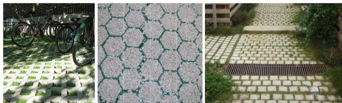
Exemple de matériaux perméables : dalle béton enherbée, gravillons, pavés non jointoyés
